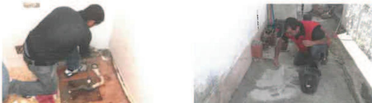
**INTERVENÇÕES EM REDES DE DRENAGEM DE ÁGUAS DOMÉSTICAS COM SUBSTITUIÇÃO DE BASE DE DUCHE E EM REPARAÇÕES DE REVESTIMENTO DE PAVIMENTOS**
