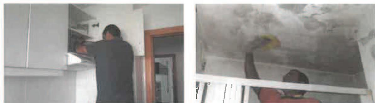
**REAPARAÇÃO DE MOBILIÁRIO FIXO E REPARAÇÃO DE REVESTIMENTOS BASE E PINTURAS EM ZONAS ONDE OCORERAM INFILTRAÇÕES**
