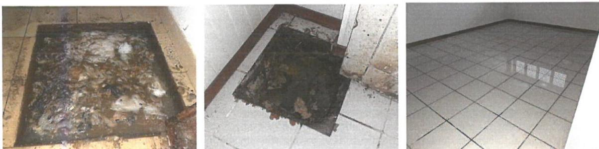
Intervenções de inspeção e desobstrução em redes de drenagem de águas residuais que reiteradamente são alvo de utilização indevida causando danos e incómodos a todos os Beneficiários
